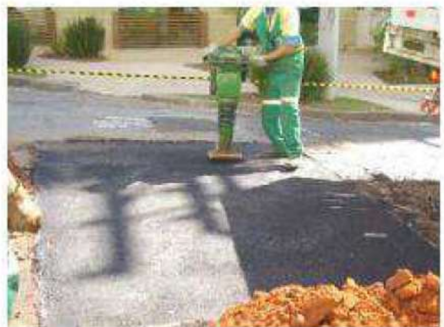
Figura 4: Aplicação e compactação do C.B.U.Q.
