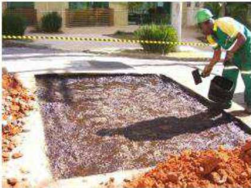
Figura 3: Pintura de ligação na base para recebimento do C.B.U.Q.
