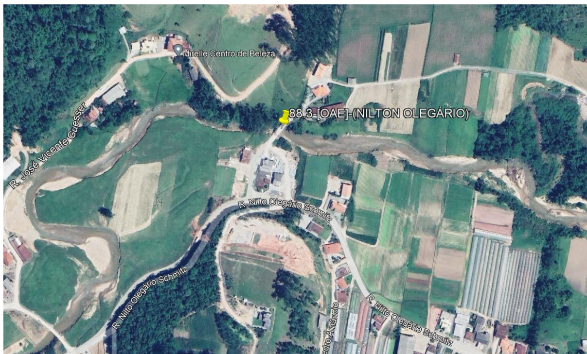
Figura 1 - Localização da Obra de Arte Especial. Fonte: Google Earth.
