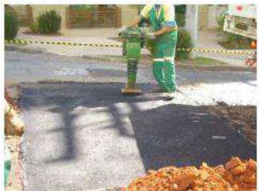
Figura 4: Aplicação e compactação do C.B.U.Q.
