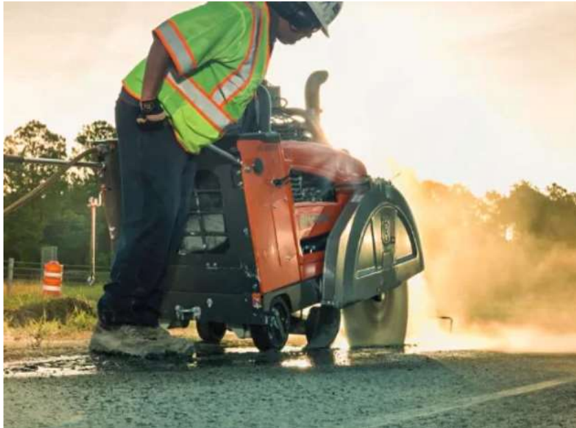
Figura 1: Corte de pavimento asfáltico com disco diamantado.
