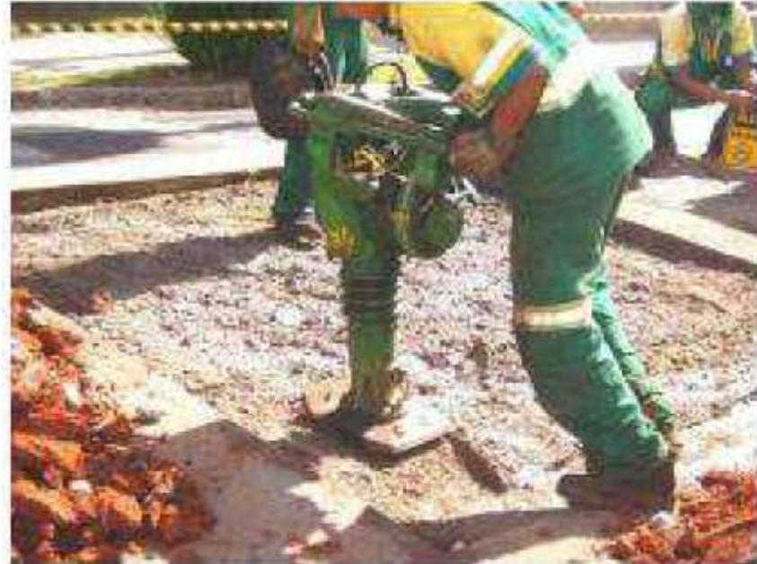
Figura 2: Readequação da camada de base.
