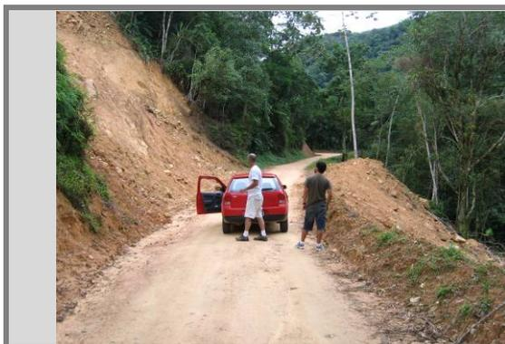
Figura 50: ESCORREGAMENTO EM TALUDE DE CORTE SC-408 (PONTO 01)
