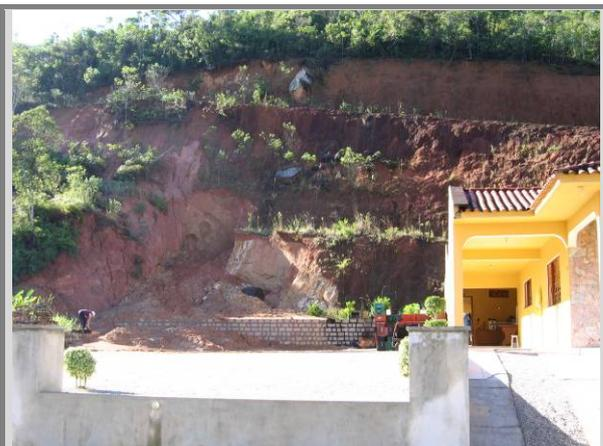
Figura 57: ESCORREGAMENTO EM CORTE DE ESCAVAÇÃO PARA CONSTRUÇÃO DE RESIDÊNCIA (PONTO 07)
