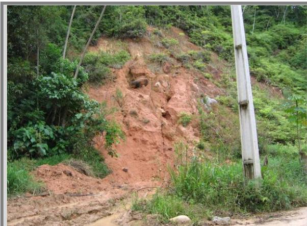
Figura 58: ESCORREGAMENTO EM TALUDE DE CORTE (PONTO 08)
