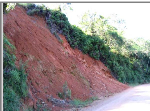
Figura 64: ESCORREGAMENTO EM TALUDE DE CORTE (PONTO 14)
