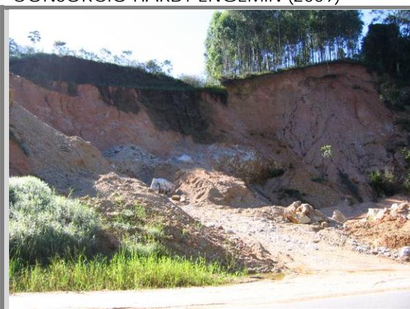
Figura 76: ESCAVAÇÃO DESORDENADA COM EROSÃO (PONTO 01)
