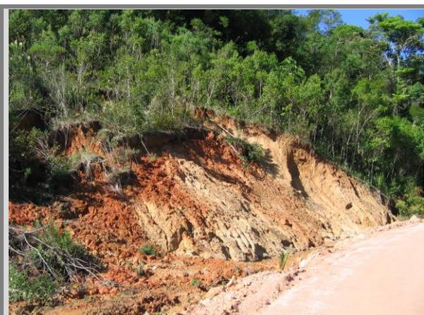
Figura 65: ESCORREGAMENTO TALUDE DE CORTE (PONTO 15)
