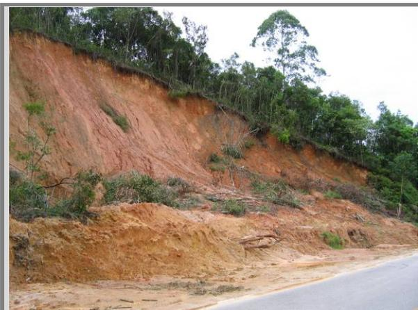
Figura 56: ESCORREGAMENTO EM TALUDE DE CORTE (PONTO 06)
