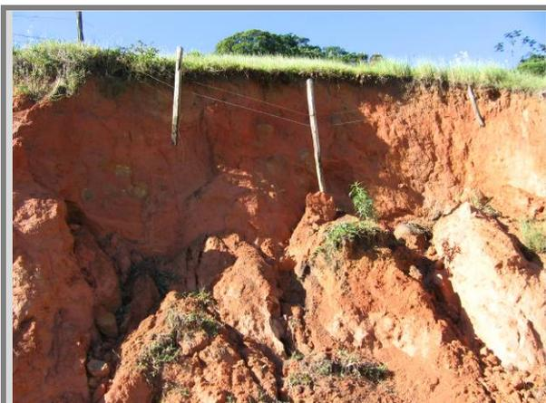
Figura 60: ESCORREGAMENTO EM TALUDE DE CORTE (PONTO 10)
