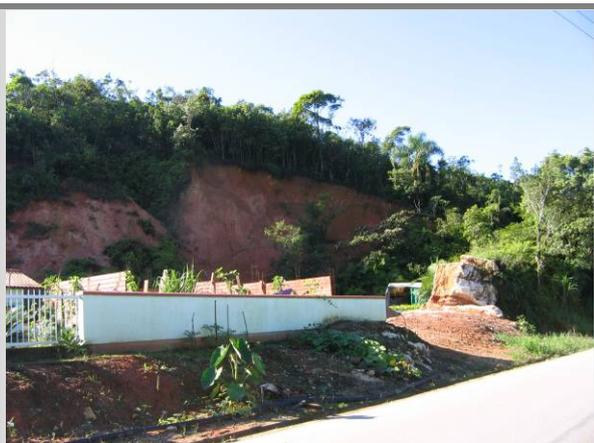
Figura 59: ESCORREGAMENTO EM CORTE DE ESCAVAÇÃO PARA CONSTRUÇÃO DE RESIDÊNCIA (PONTO 09)
