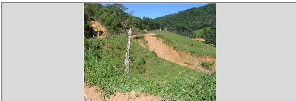
Figura 66: ESCORREGAMENTO EM TALUDE DE CORTE (PONTO 16)
