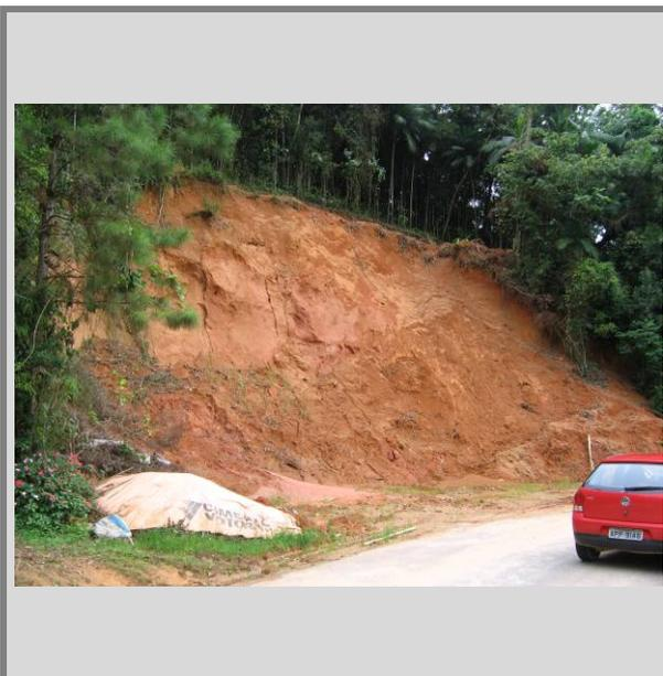
Figura 54: ESCORREGAMENTO EM TALUDE DE CORTE (PONTO 04)
