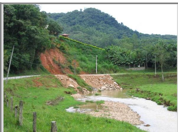
Figura 53: ESCORREGAMENTO EM TALUDE DE CORTE, COM MATERIAL CHEGANDO AO RIO RACHADEL (PONTO 03)
