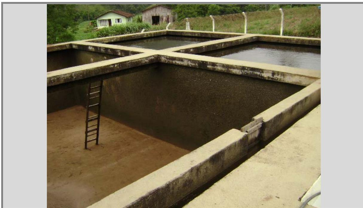
Figura 144: VISTA DO DECANTADOR E FILTRO (VAZIO) NA ESTAÇÃO DE TRATAMENTO D'ÁGUA.
