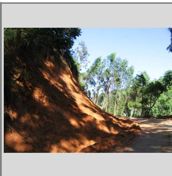
Figura 62: ESCORREGAMENTO EM TALUDE DE CORTE (PONTO 12)
