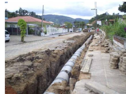
Nova rede pluvial terá tubos de 60 cm de diâmetro
