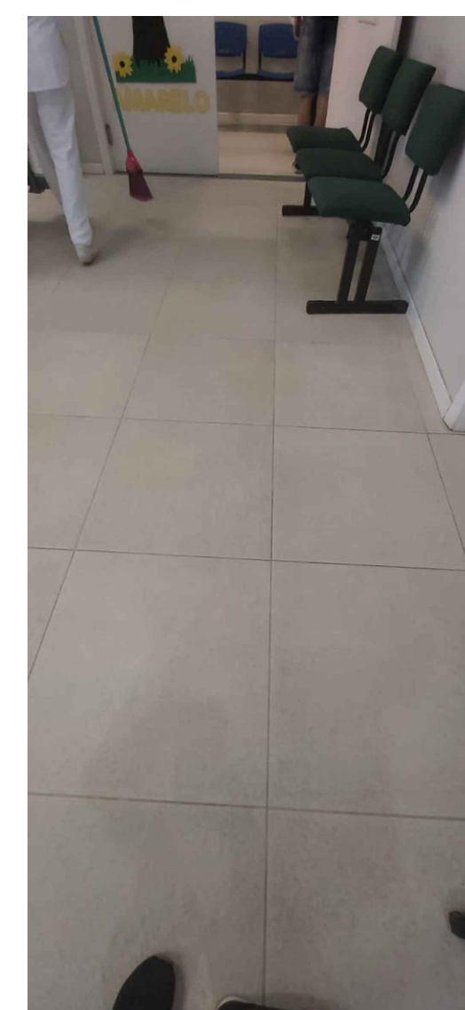
Retirar piso existente e colocar piso adequado a=105,00m²
